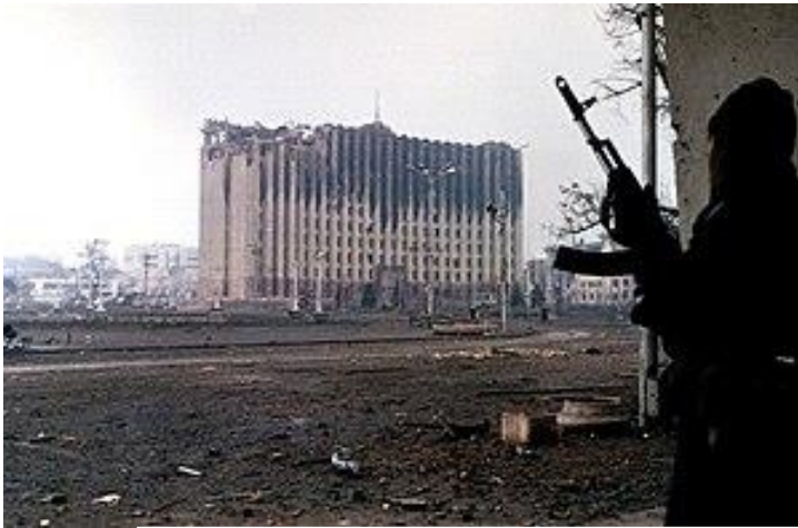
Бої навколо будівлі колишнього республіканського комітету КПРС («Президентського палацу») в Грозному, січень 1995р.
